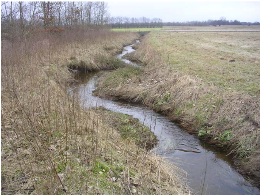
Hammerum Bæk - genslyngning ved hjælp af grødeskæring
